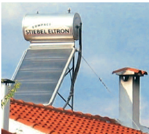
Abb. 28: Solarthermische Anlage
